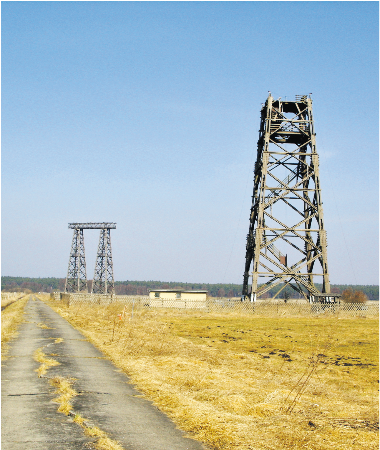
Holztürme auf dem ehemaligen Antennenmessplatz in Brück
