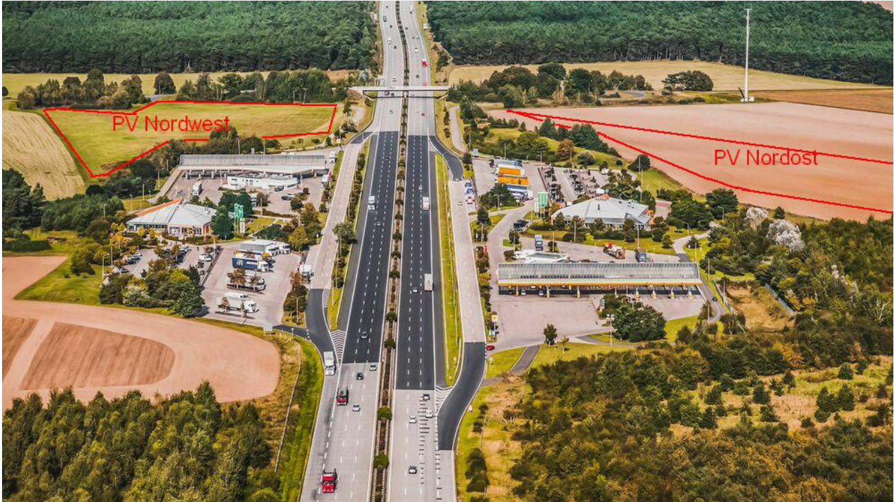
Bild 2.1.4: Blick von Süden über die Raststätte Fläming (Quelle: Google StreetView, bearbeitet)
