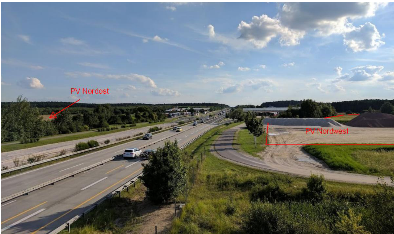
Bild 2.1.5: Blick von Norden Richtung Süden auf die Raststätte Fläming (Quelle: Google StreetView, Ausschnitt)
